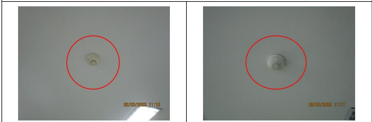
รูปที่ 34 อุปกรณ์ตรวจจับควันและความร้อน
