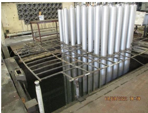
รูปที่ 10 บ่อรองรับน้ำเสียจากระบบหล่อเย็นแม่พิมพ์อลูมิเนียมบิลเลท
